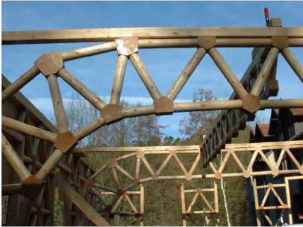
10.ábra .A „BAMBUTEC” rendszer alkalmazása rácsos tartók céljára
